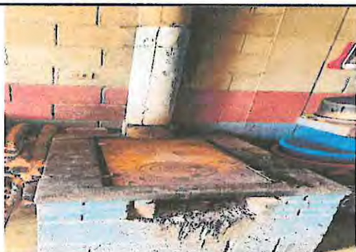
Foto 5: La plancha esta en desperfectas condiciones, la chimenea de concreto se encuentra agrietada a punto de desplomarse y la estufa rural esta en mal estado para ser utilizada.
